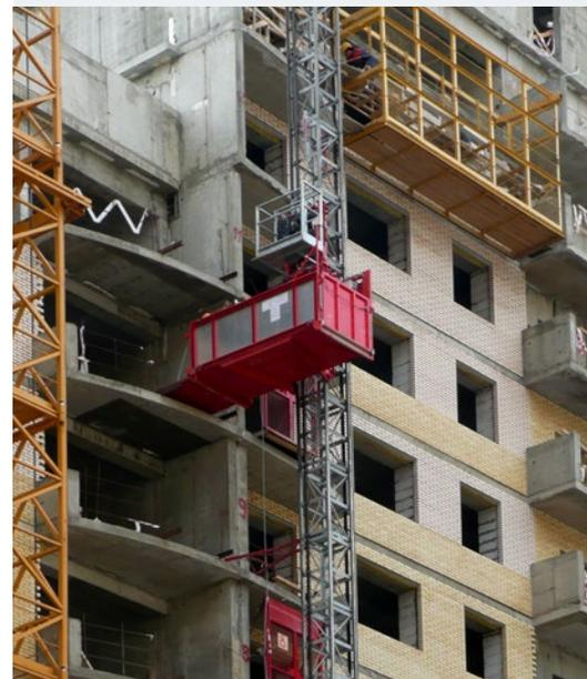
Грузовые подъемники используются при строительстве с высокими требованиями к транспортировке материала, на стройках высотных зданий, мостовых опор. Подъемники сконструированы и изготовлены, чтобы работали длительно и надежно. Длина кабины подъемника предусмотрена с 3 000 мм до 3 800 мм.
